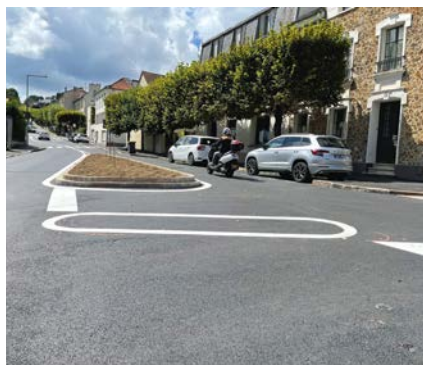
Enrobés et trottoirs nouveaux avenue Le Corbeiller.
