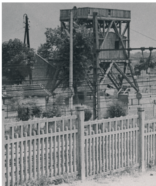
Miradors le long de la ligne ferroviaire Paris-Montparnasse.
