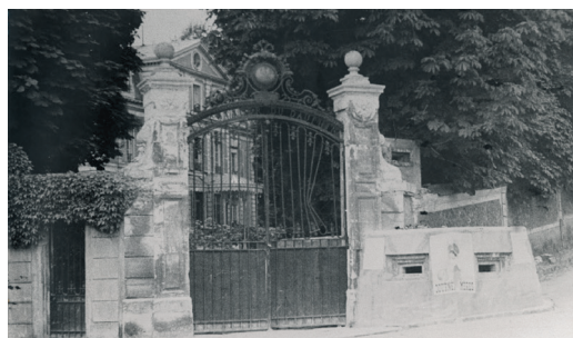
Casemate à l'entrée de la propriété du Potager du Dauphin.
